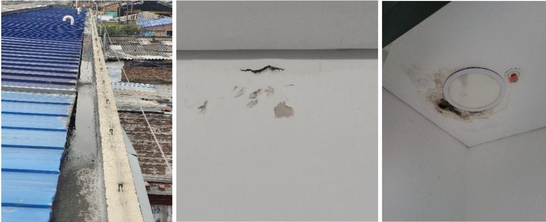
Este último puede llegar a causar daños graves y expone a riesgos a los usuarios de las áreas dado que las filtraciones y humedades han tocado elementos de luminarias que conducen energía eléctrica.
